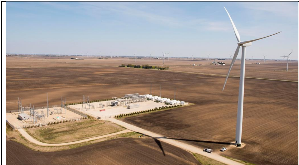
Фигура 5 Подстанция с площадка
