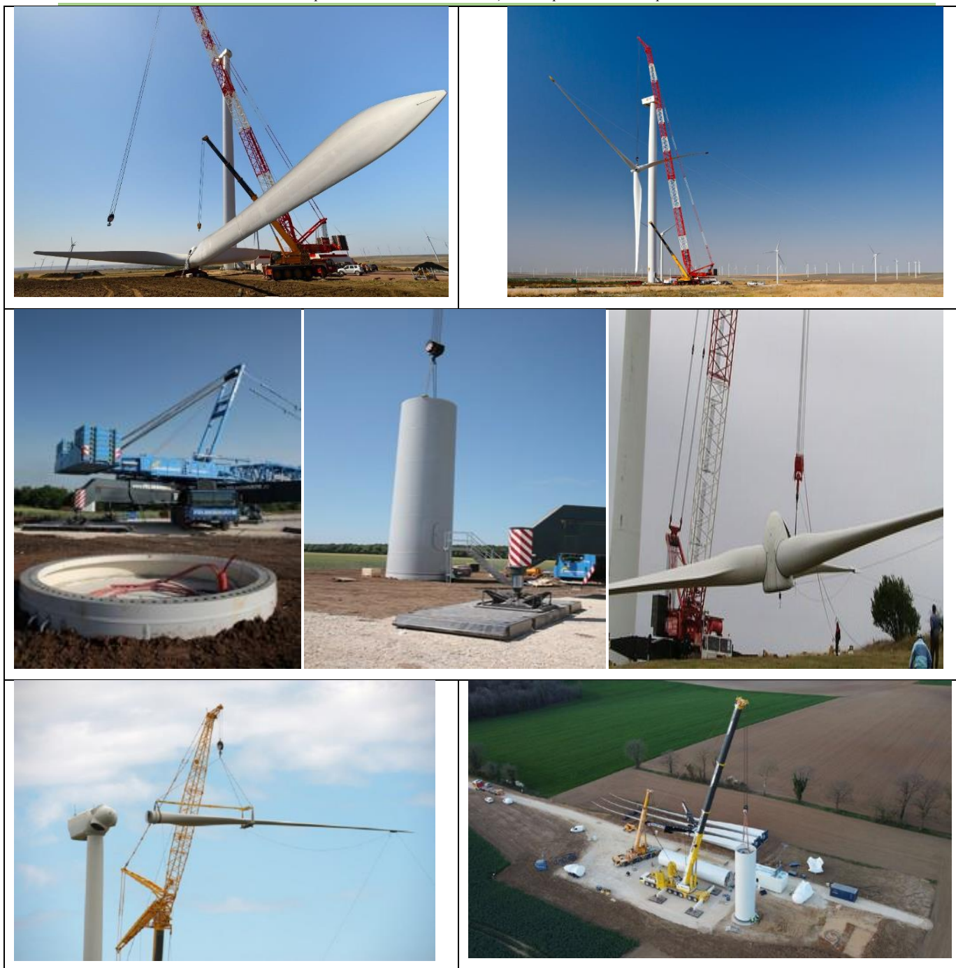
Фигура 8 Примерна схема на строително-монтажните работи (източник на изображенията: https://www.cez.cz/en/energy-generation/wind-power-plant/cezs-wind-power-plants/fantanele-cegealac-wind-park#gallery-9 )
