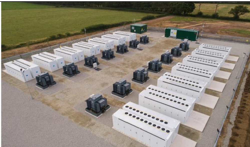
Фигура 6 Примерна площадка на съоръжения на система за съхранение на електроенергия (CSE) с капацитет 34MW-68MWh
